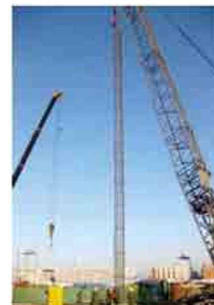
图 6 钢筋笼垂直就位
