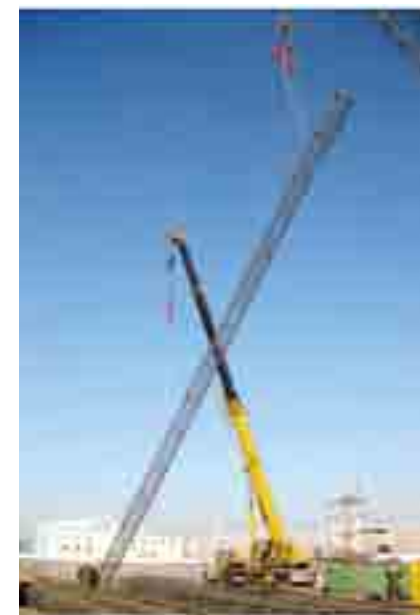
图 5 钢筋笼在空中翻转
