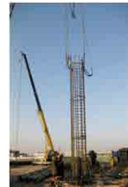
图 7 钢筋笼放置入孔
