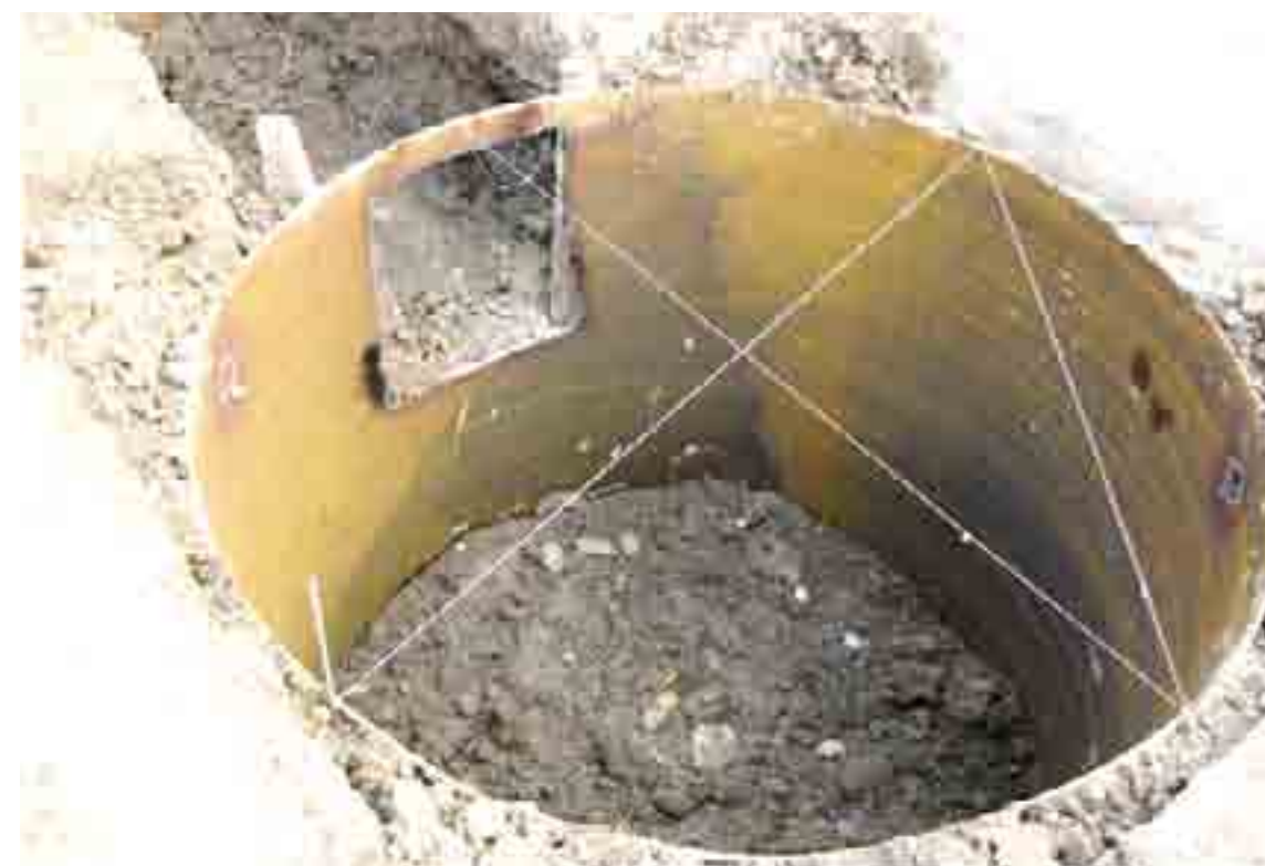
图2 混凝土灌注桩护筒埋设
