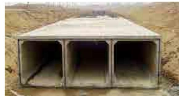
重污染和渗漏水量损失，恢复州河等天然河道的原有功能，决定新建州河输水暗渠。新建州河暗渠位于蓟县和宝坻县境内，暗渠渠首设于于桥水库电站尾水处，至九王庄节制门下流400米处与引滦明渠相接，全长34.14公里。暗渠为混凝土箱涵为3孔，单孔净断面为4.3×4.3米。其中主要建筑物包括：渠首枢纽工程（由进水闸、州河节制闸和前池组成），1座调节池，6座检修闸，2座倒虹吸，3座穿越铁路工程，4座穿越公路工程，1座出口闸，9座通气孔等。
